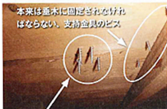
支持金具と補強板を留めているビス
